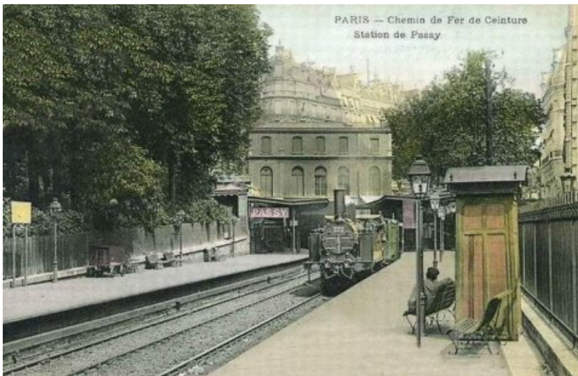
Ehem. Bahnhof Passy der Chemin de Fer de Petite Ceinture, Paris
