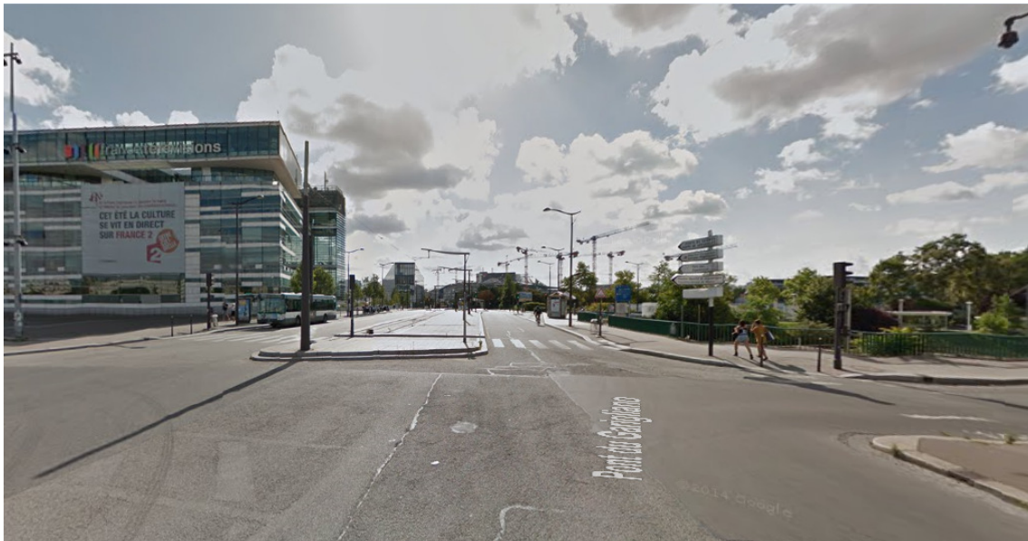
Pont du Garigliano, Paris
